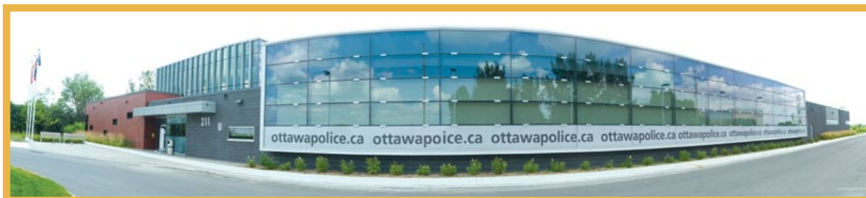
Nouvel édifice des patrouilles du District ouest situé au 211 de la promenade Huntmar.
